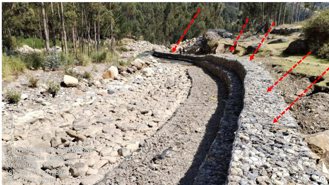
FIGURA N° 02: TRAMO CRITICO II DE LA MARGEN DERECHA DEL RIO MOSNA, SE VERIFICA EL DESBORDE Y LA NECESIDAD DE INCREMENTAR LA ALTURA DEL GAVION , EN EL SECTOR SANTA CRUZ DE MOSNA, DISTRITO DE SAN MARCOSR, PROVINCIA DE HUARI - ANCASH
